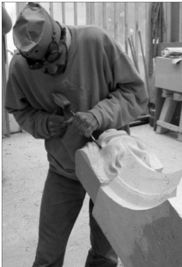
**Oben links: zerstörte Fratze. Darunter: Fratzenkopie anfertigen. Oben: Fratze ausarbeiten. Links: neue Fratze mit Maßwerk**
